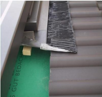
10. Die untere Schürze des Eindeckrahmens so einknicken, dass ein Abfließen des Wassers gewährleistet ist.
