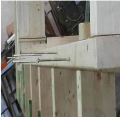
3. Den Aufbaurahmen fest mit dem Sparren bzw. Wechsel verbinden! Befestigung durch lange Senkkopf – Holzschrauben siehe Beschreibung im Aufmaßblatt.
