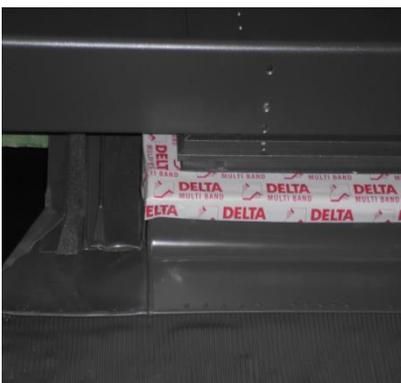
11. Den Fensterflansch und den Eindeckrahmen durch ein Gewebeklebeband miteinander verbinden!
