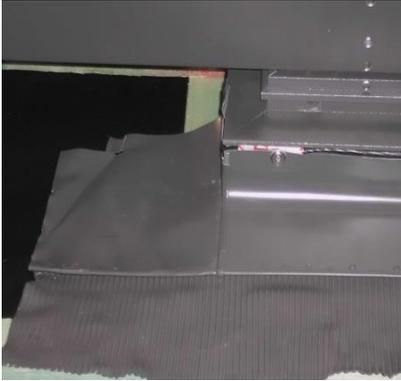
9. Den Eindeckrahmen umlaufend mit Spenglerschrauben (im Lieferumfang enthalten) am Aufbau-rahmen montieren.
