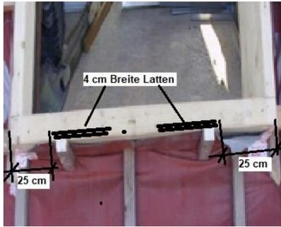
5. Hilfsplatten am unteren Aufbaurahmen befestigen/anschrauben.
